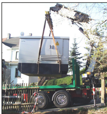
Aufstellung einer NDV400 mit LKW-Kran
