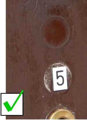
Şek. 14: İyi durumda. Yüzeylerde ve boyalarında küçük düzensizlikler
