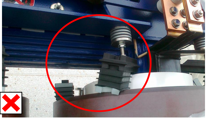
Şek. 15: Yasak! Sarımlar kaydırmış. Devrilmiş desteklerden anlaşılır.
