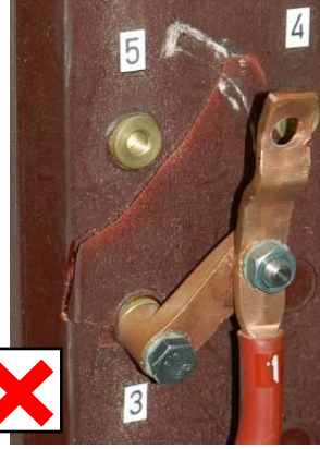
Şek. 12: Yasak! Şalt bağlantısına güç uygulama sonucu yüzeyde patlamalar
