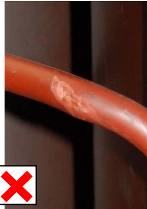
Fig. 11 : Interdit ! Isolation déformée d'une connexion
